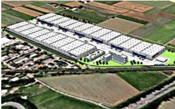
Die neue Zentrale (Bild: Pfenning)
