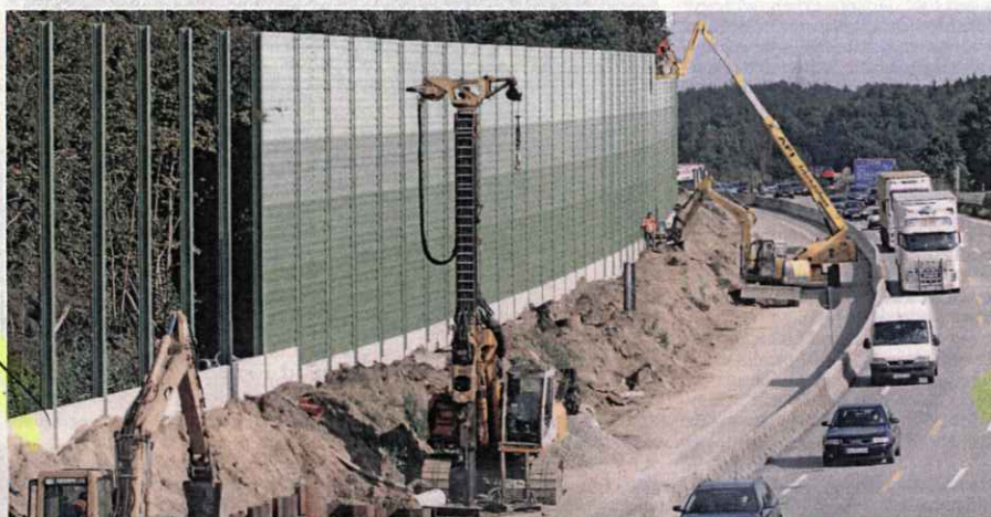
Bau einer Lärmschutzwand an der A1: Durch Lkw verursachte Lärmkosten können künftig angerechnet werden.
