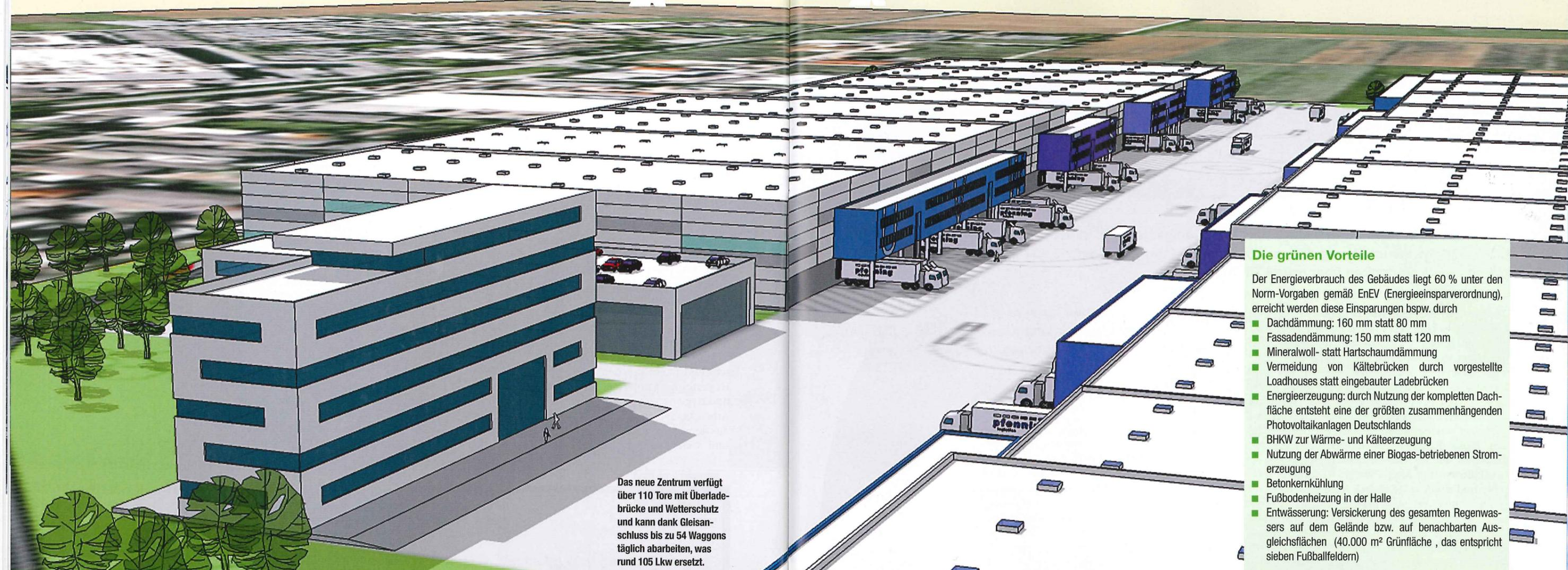
Das neue Zentrum verfügt über 110 Tore mit Überladebrücke und Wetterschutz und kann dank Gleisanschluss bis zu 54 Waggons täglich abarbeiten, was rund 105 Lkw ersetzt.
