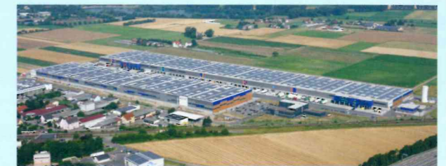
Das Luftbild des Multicube Rhein-Neckar zeigt auch die größte kristalline Aufdach-Solaranlage Europas.
