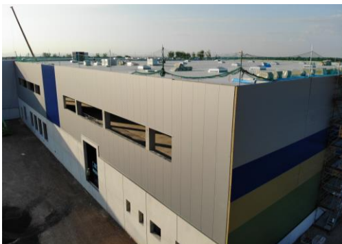
Das im Bau befindliche Logistikzentrum. Foto: Krüger Consult GmbH
